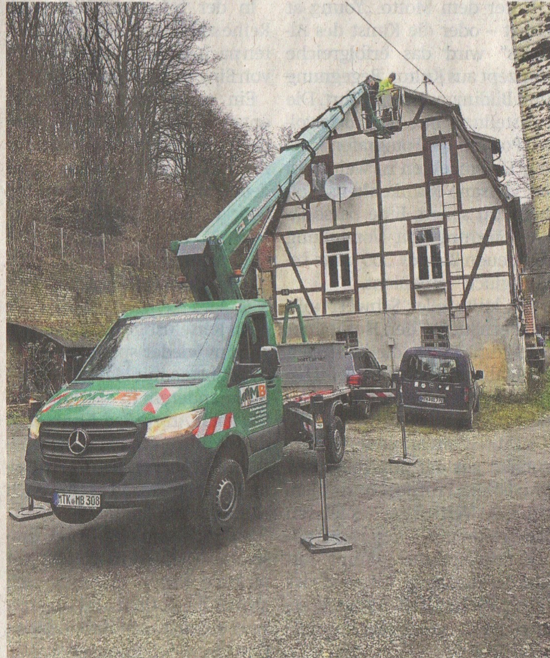
An der ehemaligen Lederfabrik in Lorsbach finden Turmfalken nun einen guten Nistplatz.
