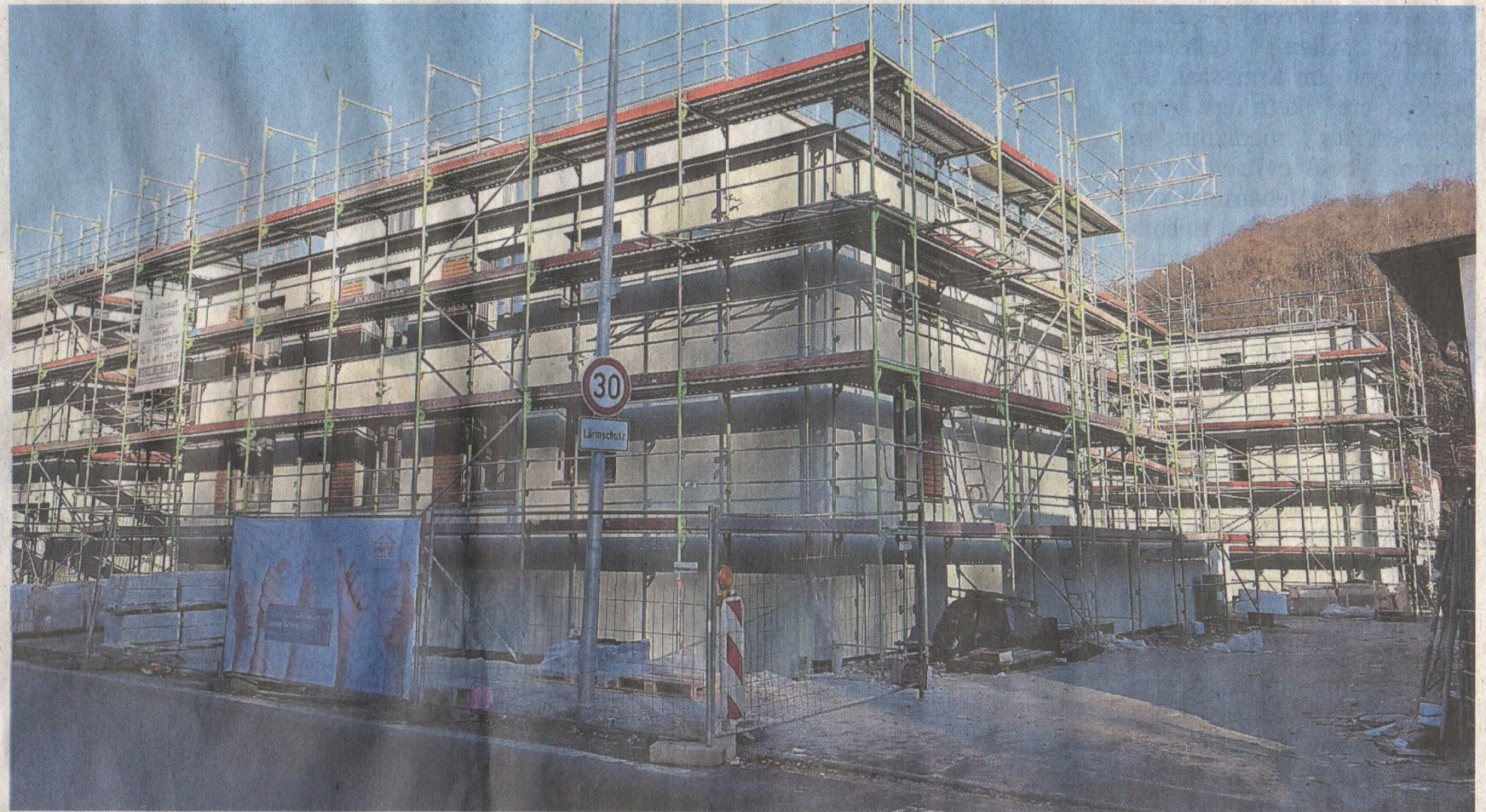
Die Erstellung der Gebäude an der Hofheimer Straße 53–55a liegt im Zeit- und Kostenplan.
