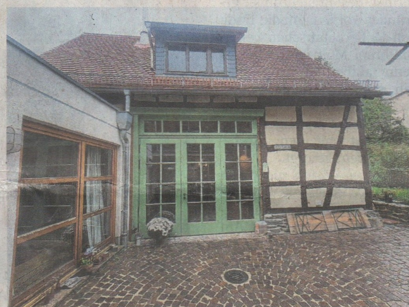
Blick auf das Gebäude aus dem 18. Jahrhundert.
