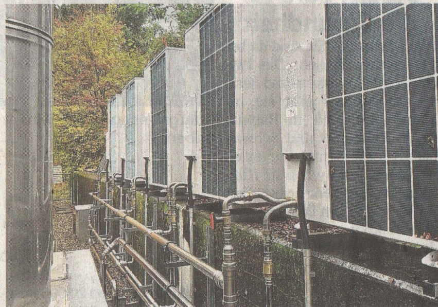
Die TVL-Sporthalle wurde umfassend mit neuester Heiztechnik umgerüstet ESTHER FUCHS (2)
