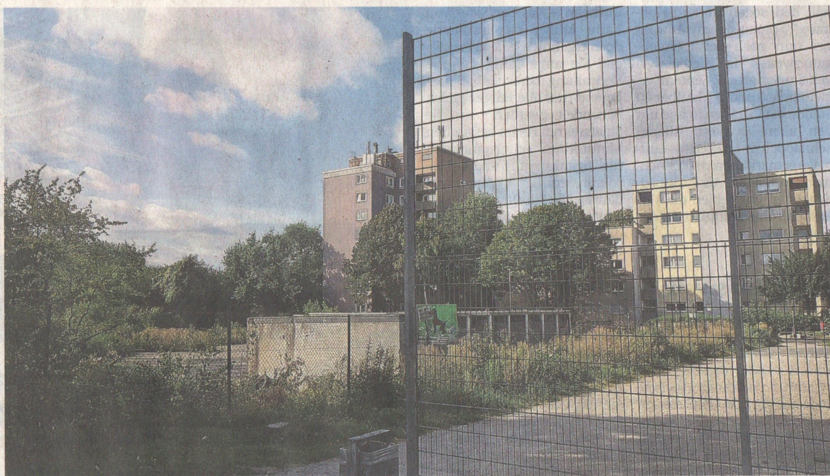
In direkter Nachbarschaft des Finanzamts wird die HWB nun bauen, der Garagenhof wird bald abgerissen.
