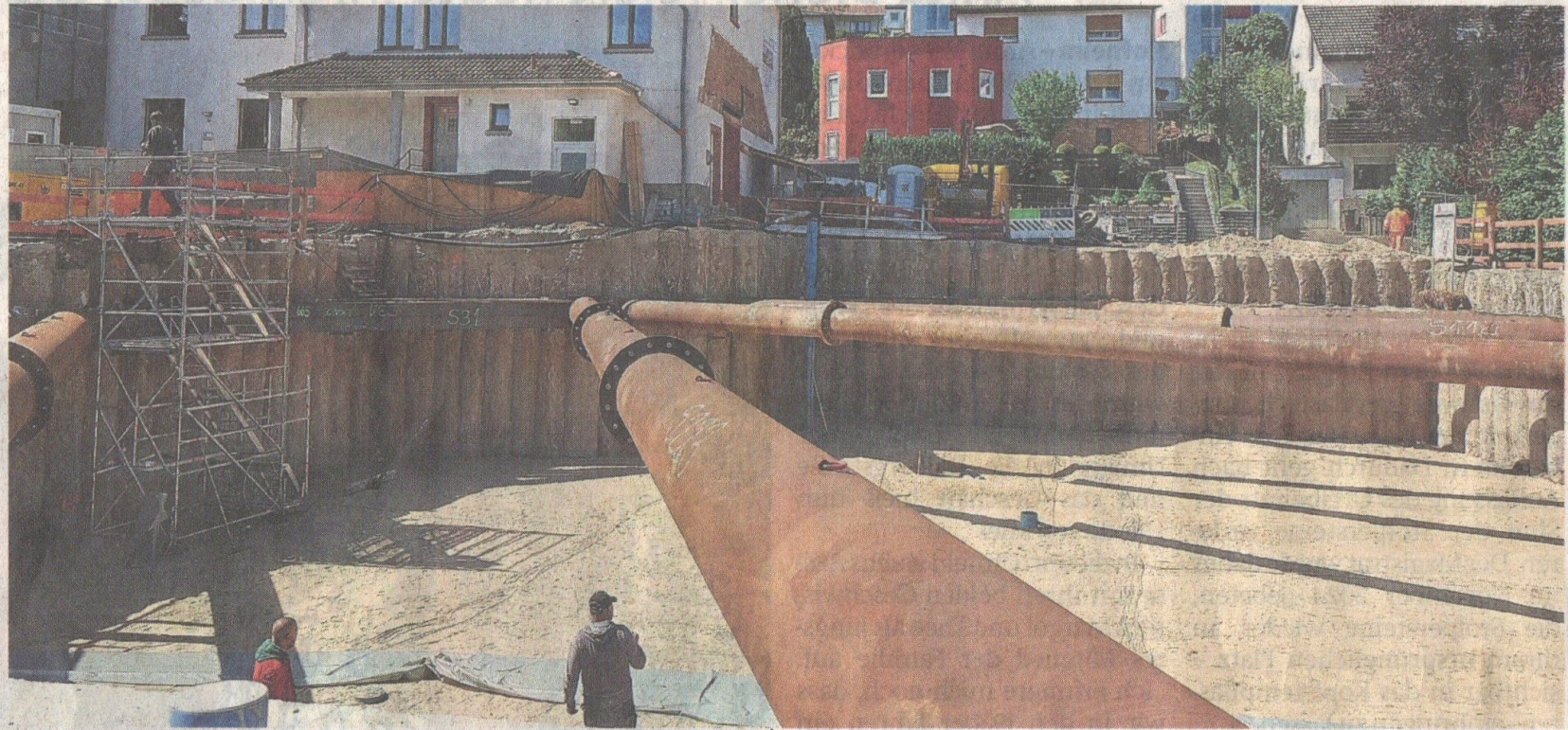
Mit überschnittenen Bohrpfählen und Stahlrohren ist die Grube des Erweiterungsbaus gesichert.
