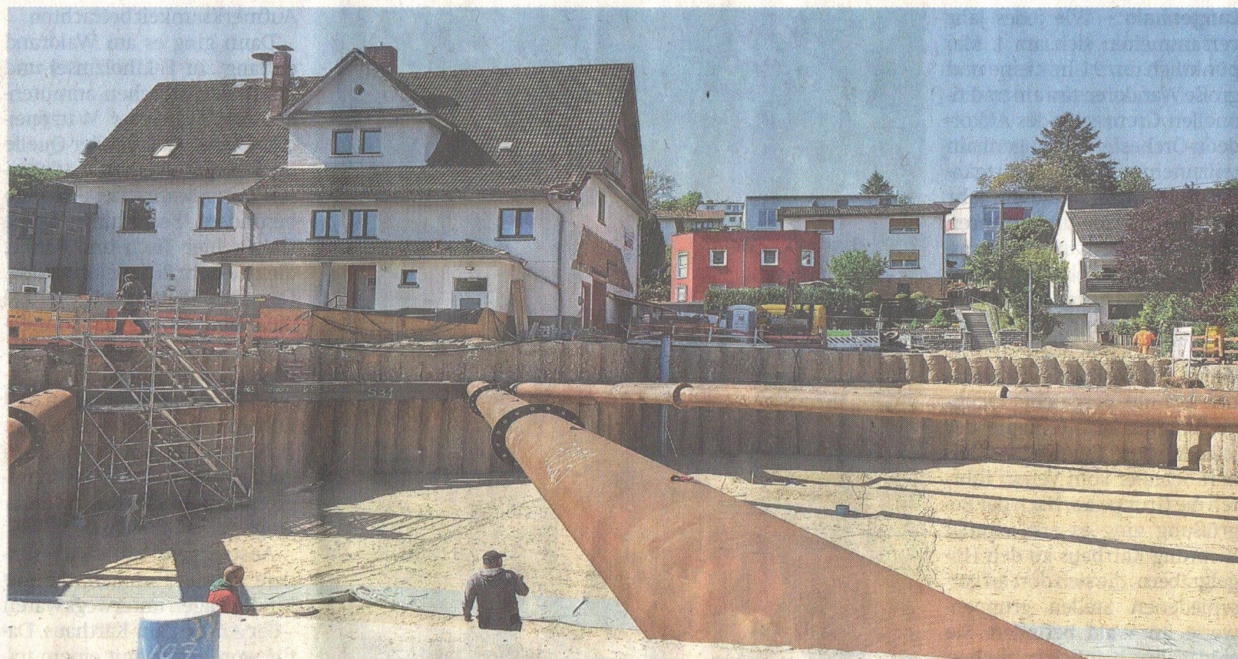
Mit überschnittenen Bohrpfählen und Stahlrohren ist die Grube des Erweiterungsbaus gesichert.
