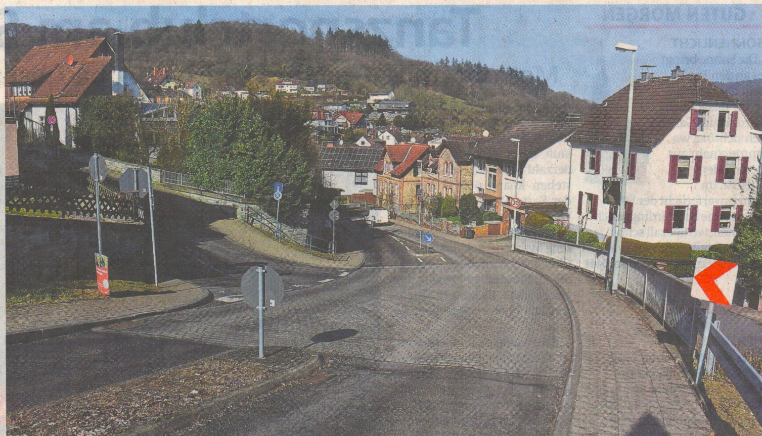
Auch eine Extra-Markierung auf der L3368 an der Einmündung „Am kleinen Feld“ (links) hält die Verwaltung für überflüssig. BT
