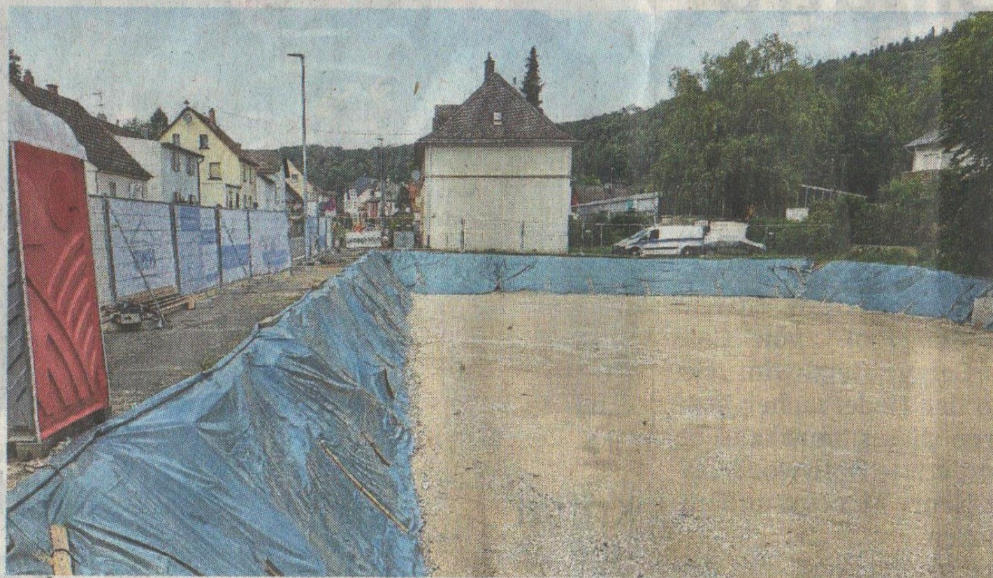
Die Baugrube für die drei Gebäude, in denen insgesamt 18 Wohnungen entstehen sollen, wurde bereits ausgehoben.
