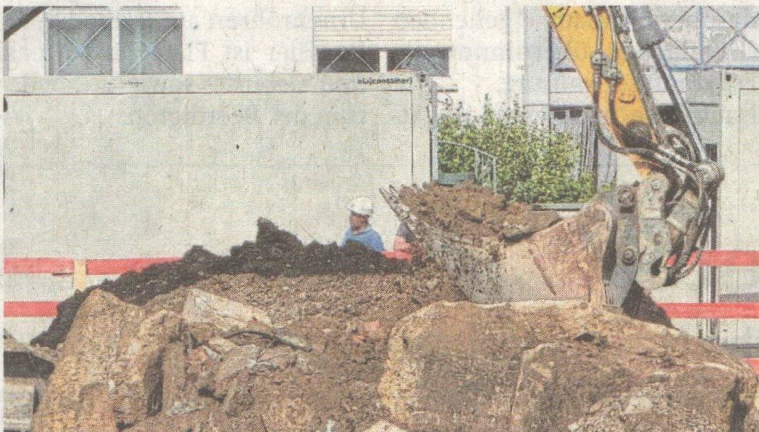
Bei der Bebauung des Nahkauf-Geländes fotografierte der Lorsbacher Thomas Gerner bei der Aushebung der Baugrube Reste alter Fundamente.
