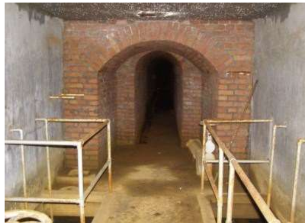
Blick vom Eingangsbereich in den anfangs ausgemauerten Stollen
