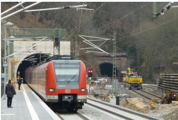
Der neue Tunnel kurz nach seiner Eröffnung vom Eppsteiner Bahnhof aus gesehen. Im Hintergrund das alte Tunnelportal
